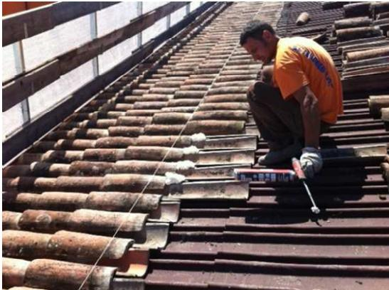
*Sono iniziati i lavori di manutenzione straordinaria alla copertura del Palazzo di Residenza in Corso Italia 45, vengono completamente risistemati i coppi con la sostituzione di quelli ammalorati e posizionata l'ondulina nonché rifatte tutte le grondaie e le converse in rame.*
